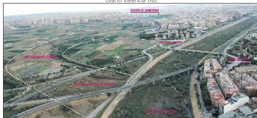
Figura 31: Imagen aérea donde se puede apreciar el lugar exacto en el que se desvió el río tras la ejecución del plan sur. Fuente: Diario Valencia Hui.
